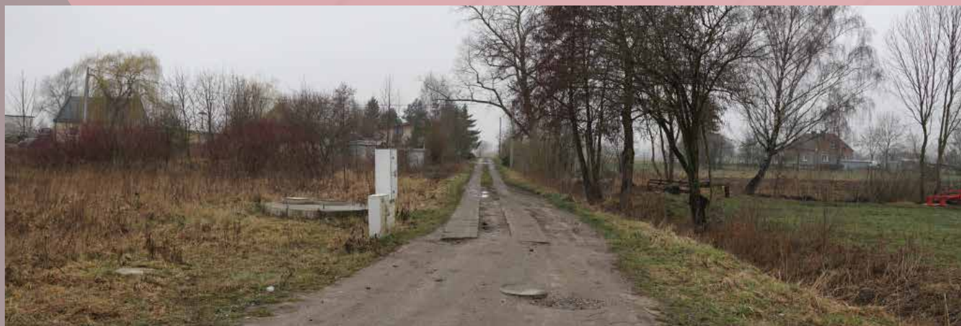
Budowa drogi pieszo-jezdnej w miejscowości Długie Pole o długości (1289 mb) wraz z budową, nowej sieci wodociągowej spinającej Leszkowy z Cedrami Wielkimi
