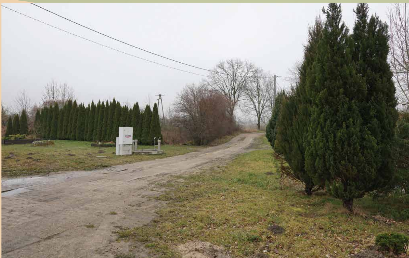
Remont drogi w Długim Polu, Gmina Cedry Wielkie, dz. nr 149
